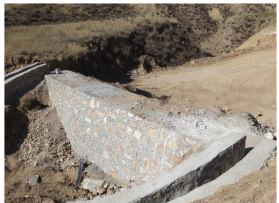
排矸场挡矸墙
