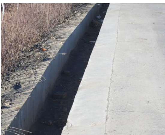
工业场地进场道路排水沟
