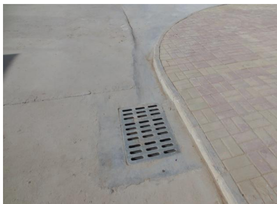
新增行政生活区排水沟
