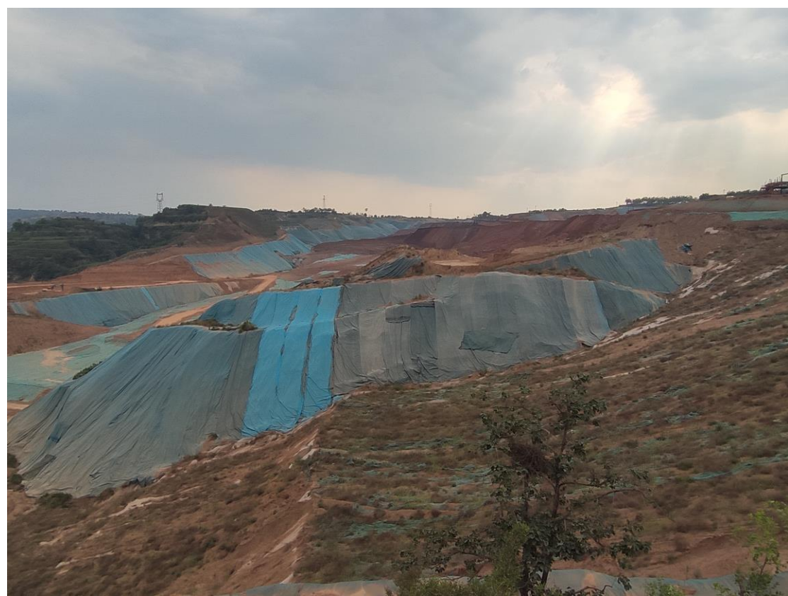
坝体正在堆置
